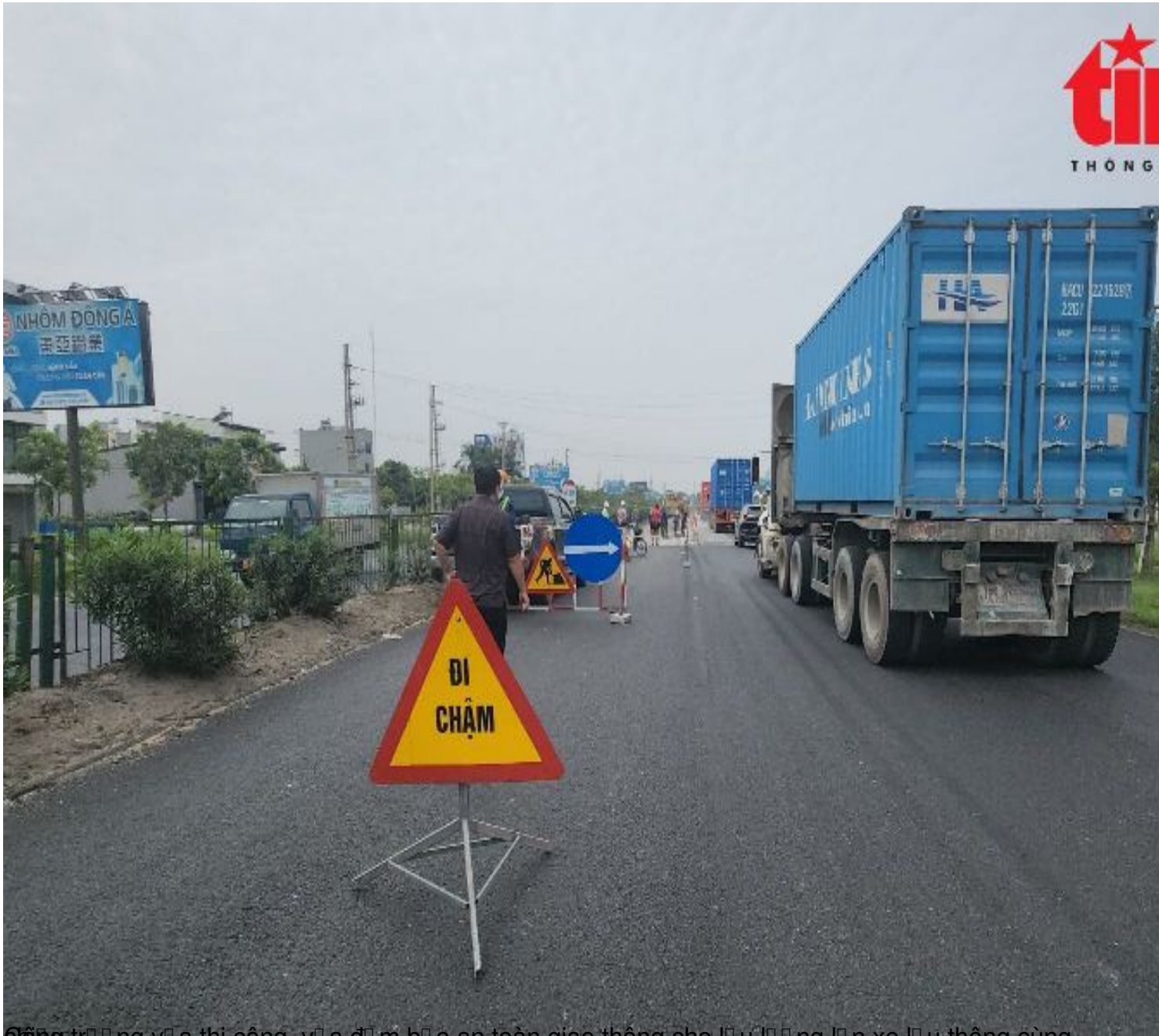
Công trình vỉa hè thi công, vỉa hè đảm bảo an toàn giao thông cho lưu lượng lớn xe lưu thông cùng
