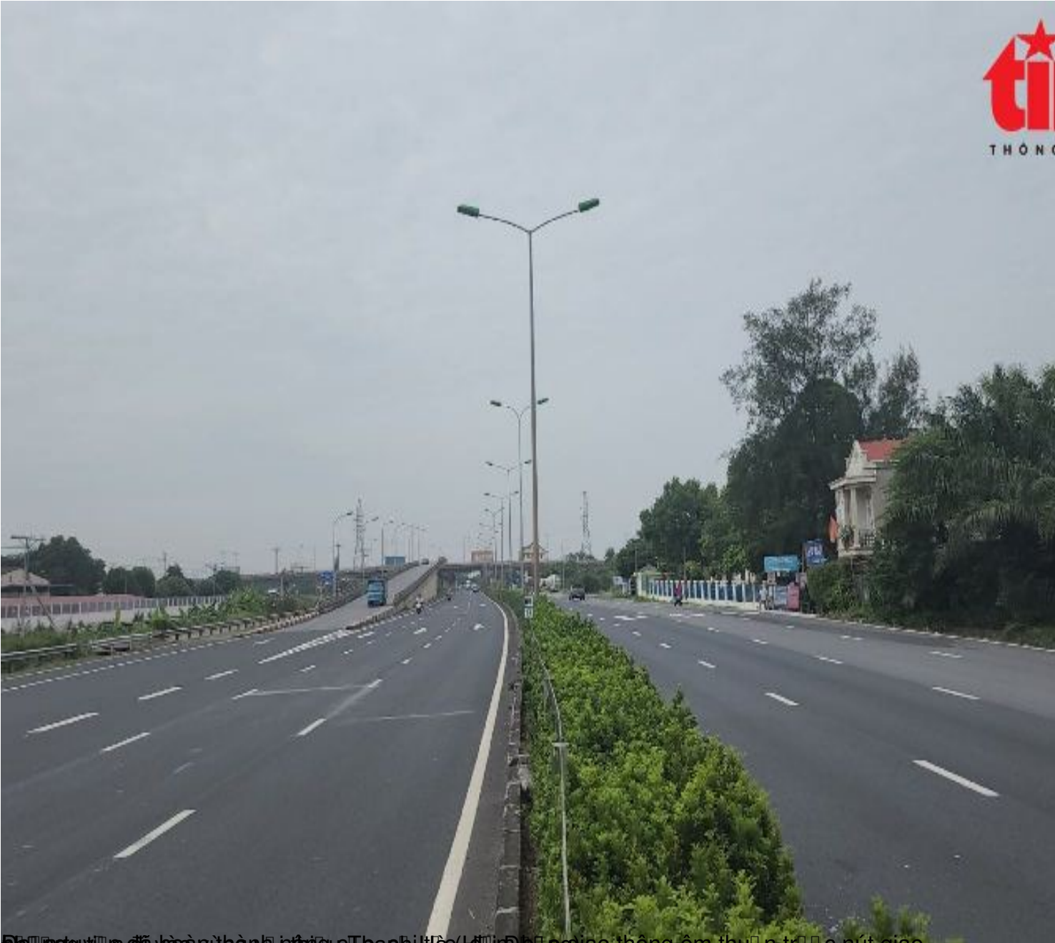
Đường mới đã vào hệ thống TP. Hà Nội, kết nối giao thông êm thuận trực tiếp giao
