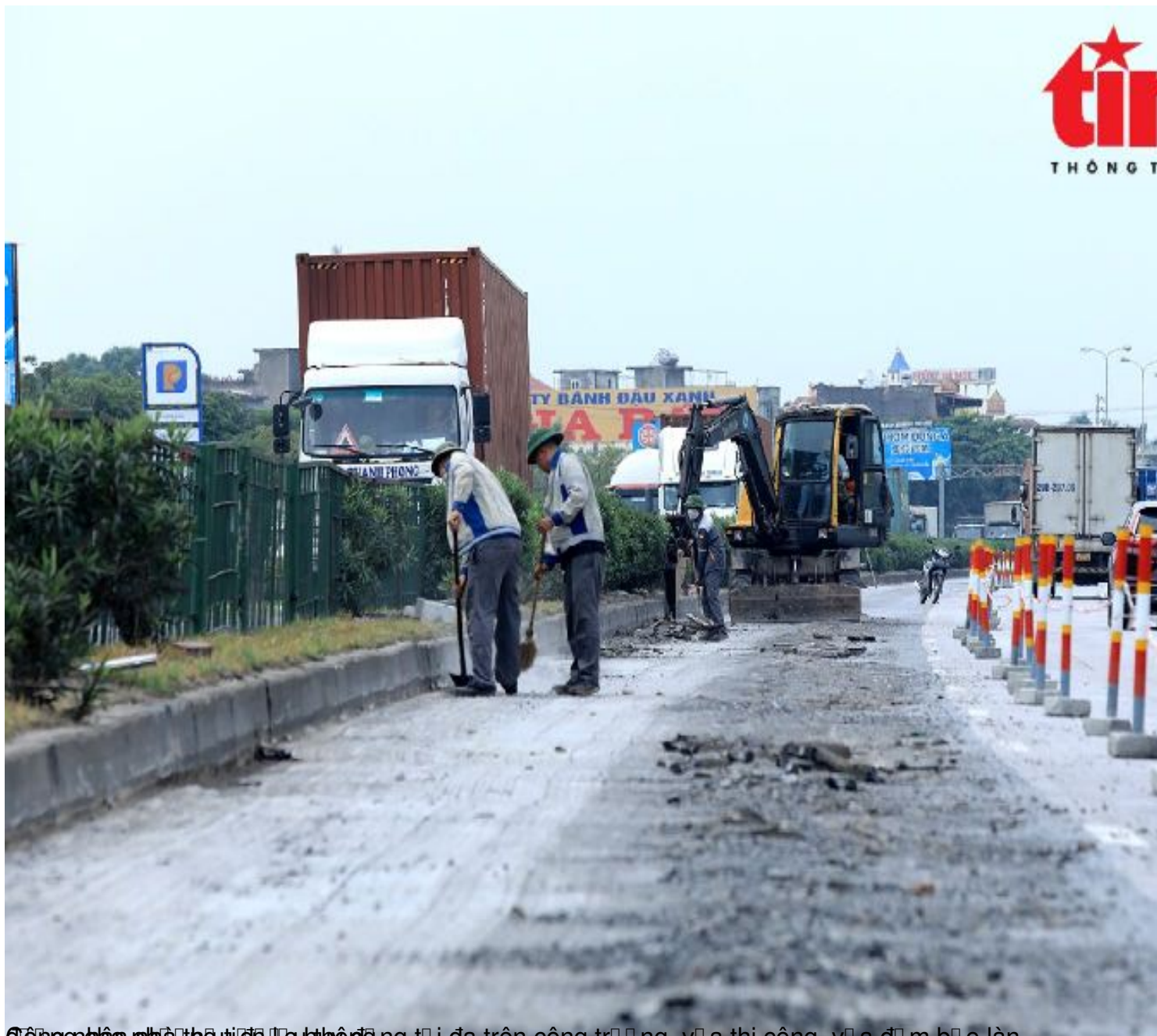
Công nhân phá dỡ vỉa hè cũ để thi công vỉa hè mới trên công trường, vỉa hè thi công, vỉa hè đã mìn bỏ làn
