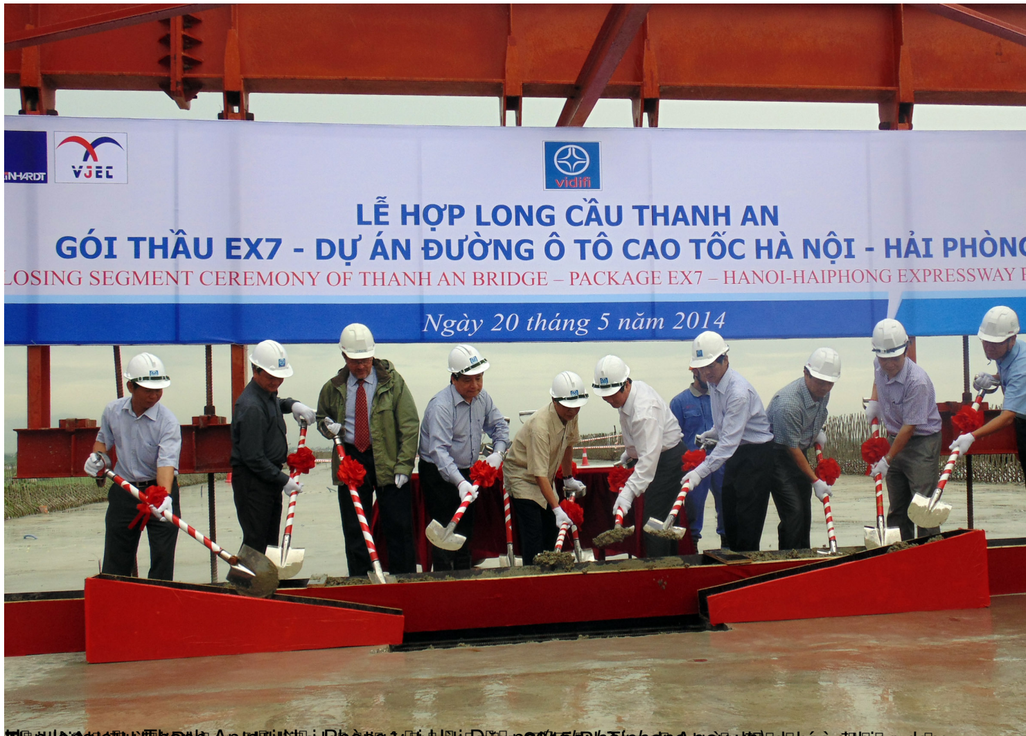
Thống đốc tỉnh Hải Phòng, Ủy viên Bộ Chính trị, Bộ trưởng Bộ Giao thông Vận tải Phạm Hồng An (từ trái qua phải) cùng các lãnh đạo tỉnh, đơn vị liên quan tham gia lễ hợp long cầu Thanh An.
