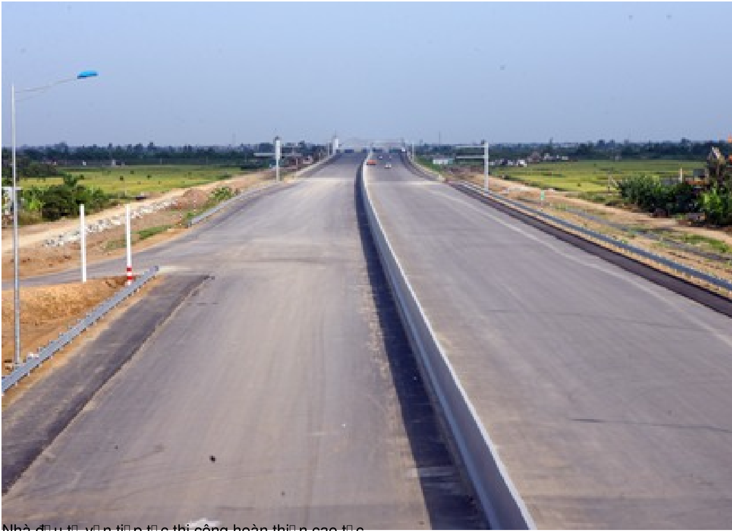
Nhà đầu tư vốn tiếp tục thi công hoàn thiện cao tốc
