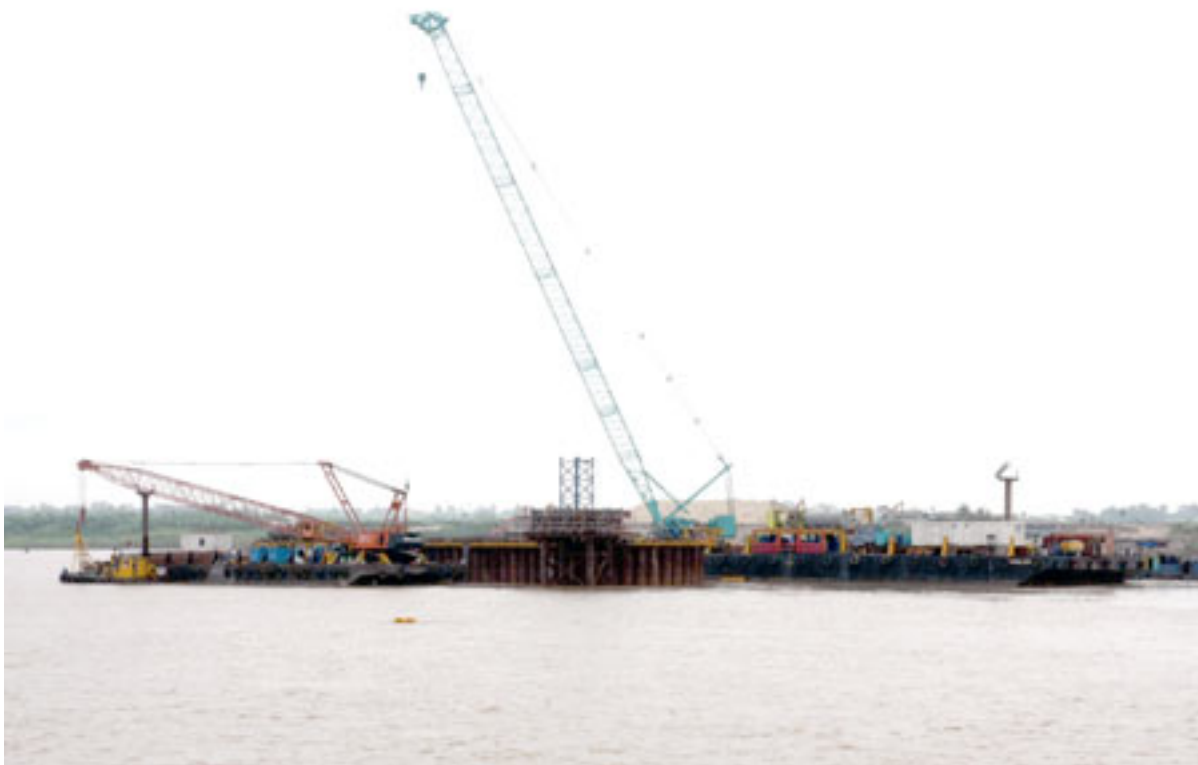
Thi công cớ u Nhố t Tân. ố nh: Khánh Hà
