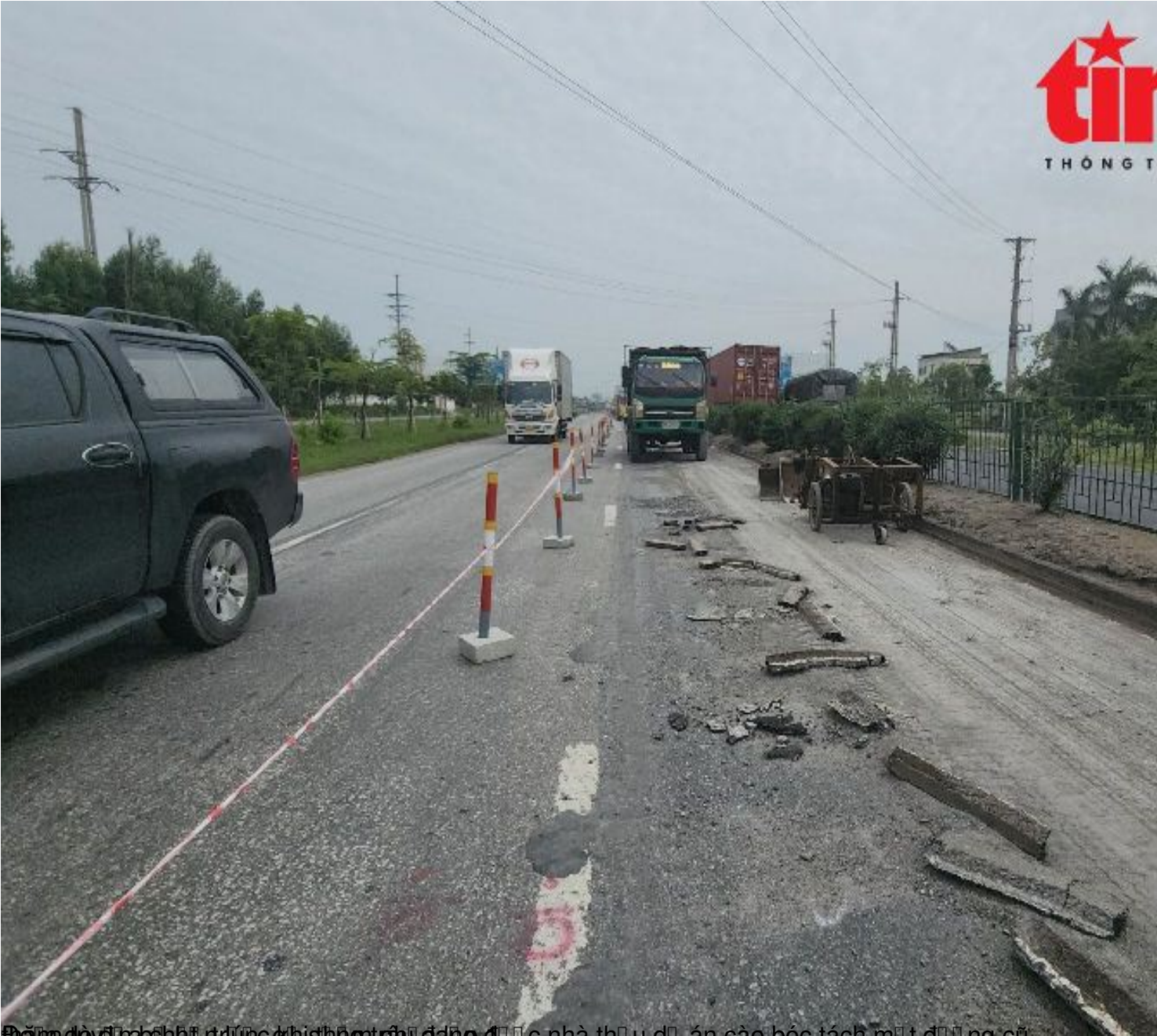
Đảm bảo chất lượng thi công trước khi đưa vào sử dụng. Nhà thầu dự án cào bóc tách mặt đường cũ,
