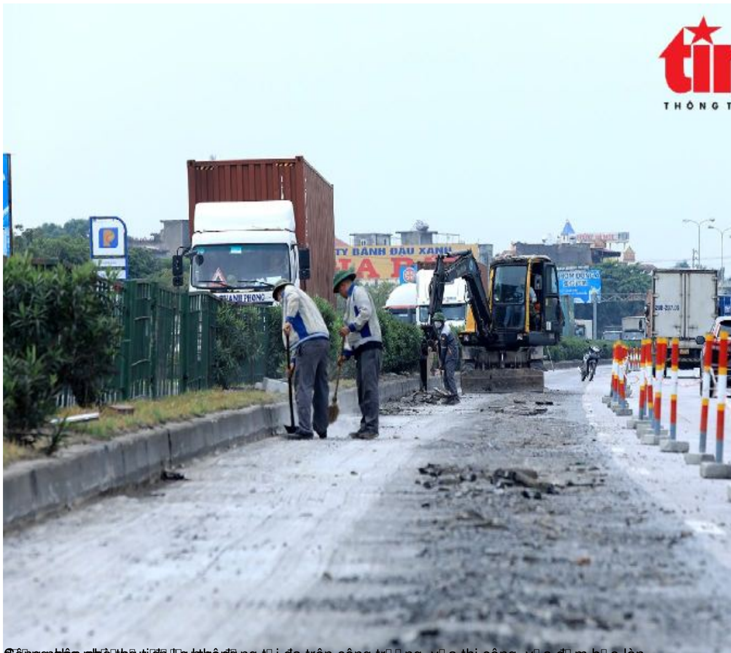
Công nhân phía thượng nguồn của dự án đã thi công, và đã m b o làn
