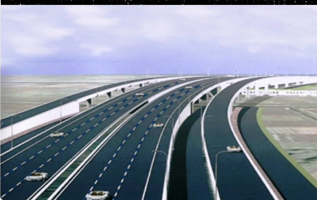
Chiều dài tuyến đường cao tốc Hà Nội - Hải Phòng là 200,5 km, trong đó có 132,5 km là đường cao tốc và 68 km là đường cấp III. Toàn tuyến có 10 nút giao thông, trong đó có 7 nút giao thông cao tốc và 3 nút giao thông cấp III.
