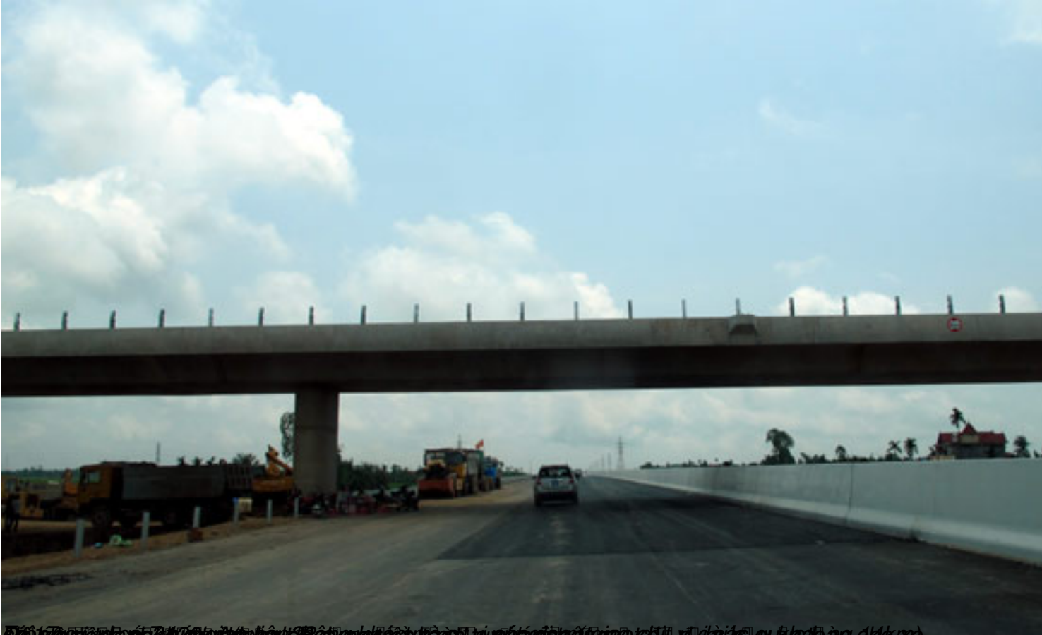
Đường ô tô cao tốc Hà Nội - Hải Phòng 6 làn xe đang thi công tại địa điểm này.
