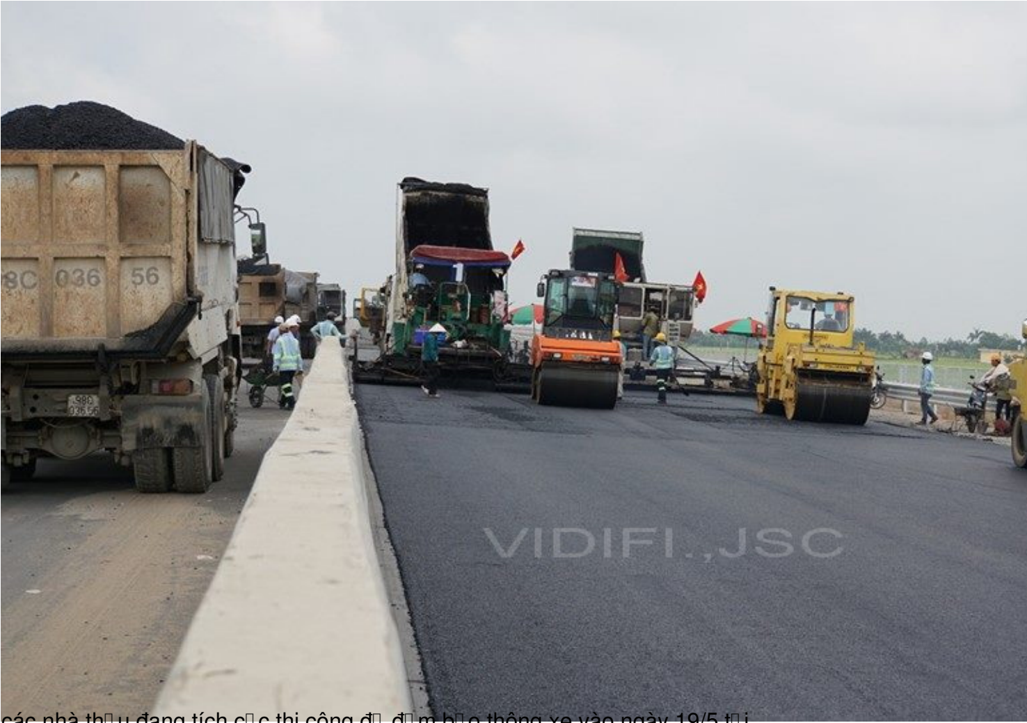
các nhà thầu đang tích cực thi công để đảm bảo thông xe vào ngày 19/5 tới
